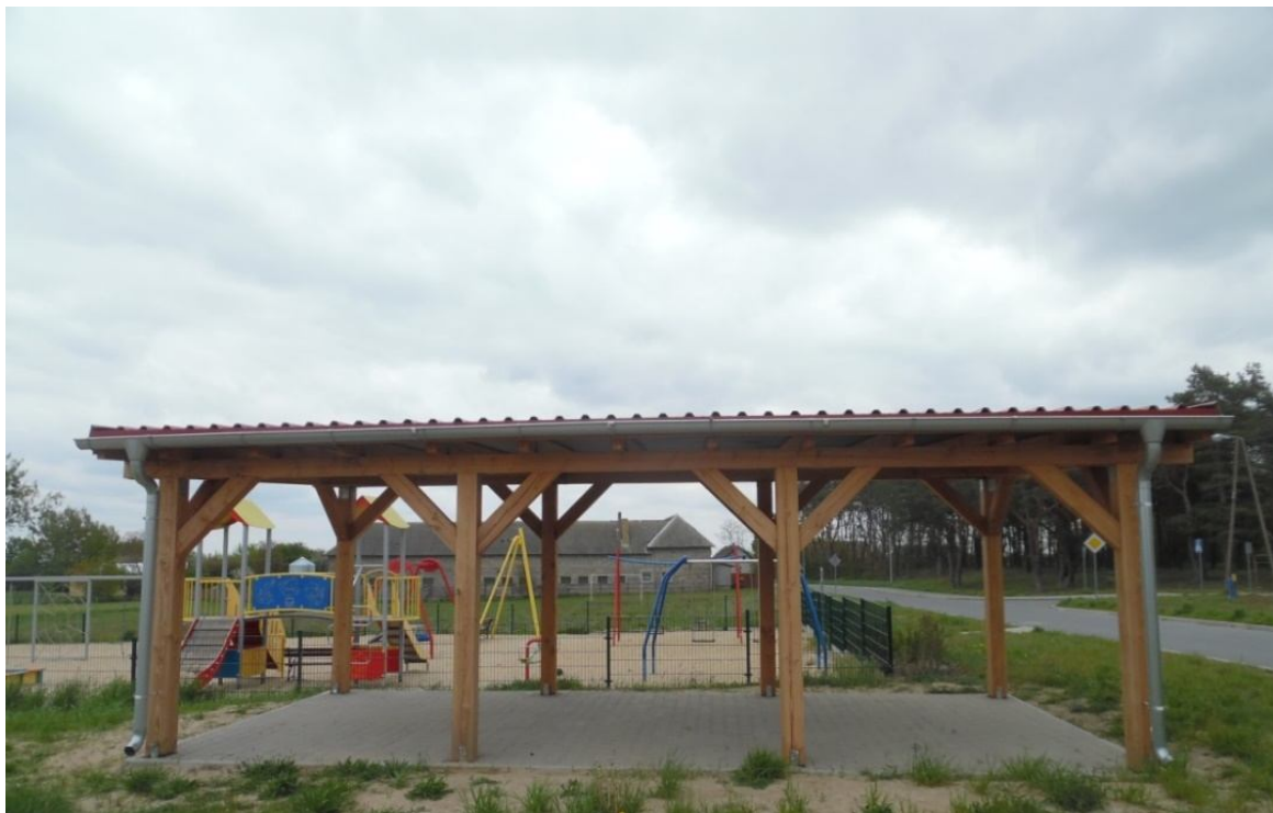
Budowa wiaty w miejscowości Bukowiec
